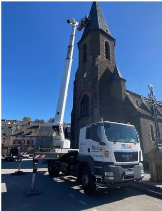
intervention. Le clocher nécessitait un important entretien d'étanchéité et également un contrôle de fixation de la croix en son sommet. Les travaux ont été réalisés par l'entreprise BUFFIÈRE grâce à une nacelle spécifique de 46 mètres louée chez TEIL.
